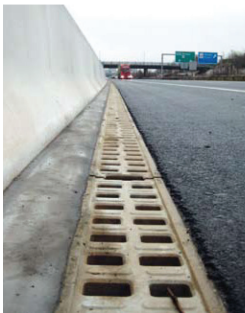
ARKIL A/S – ANLÆG fik til opgave at installere afvandingsrenderne.
