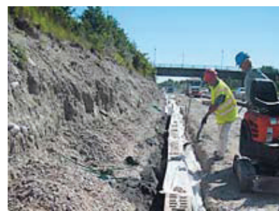
ARKIL A/S – ANLÆG fik til opgave at installere afvandingsrenderne.
