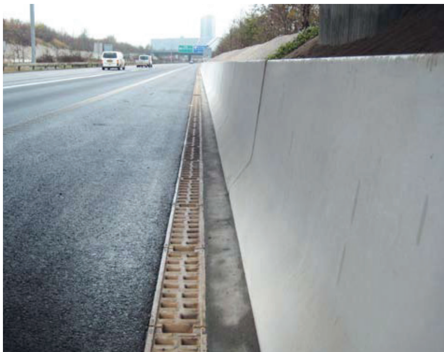
ACO MONOBLOCK 200 er kendetegnet ved sin monolitiske udformning, der gør den yderst trafikssikker.
