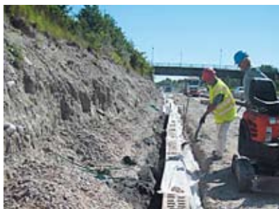
ARKIL A/S – ANLÆG fik til opgave at installere afvandsrenderne
