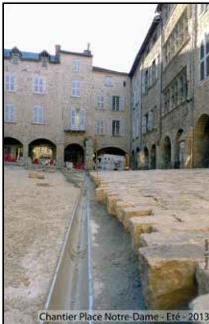
Pose des caniveaux ACO.
