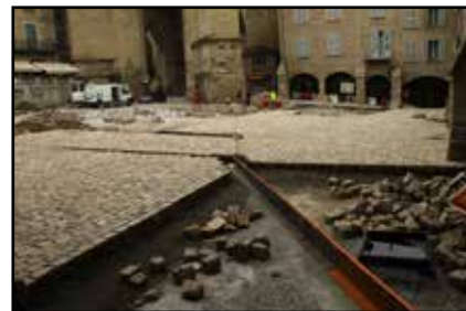
Pose de la fente en acier corten.
