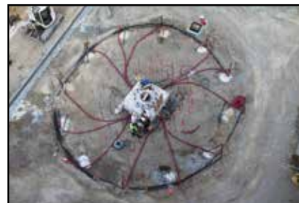
Mise en place des jeux de lumière et jets d'eau
