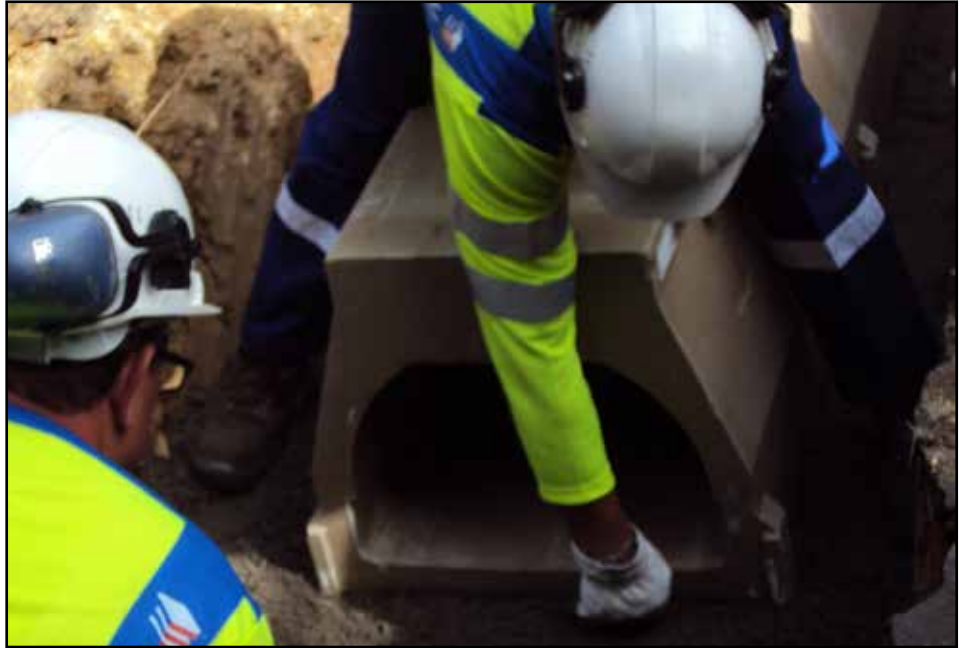
Pose des crapauducs dans la tranchée.
