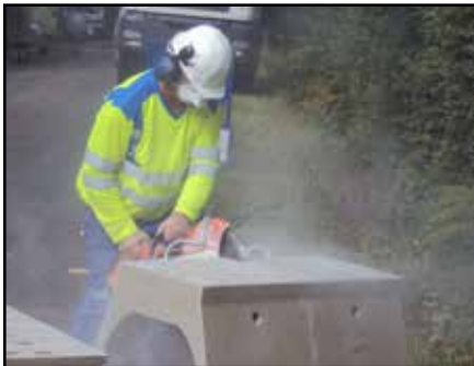
Découpe des éléments en fin de ligne
