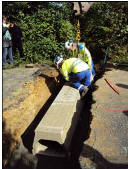
Rampe de caniveaux installés
