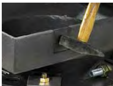
Åbning af afvanding i byggeperioden
