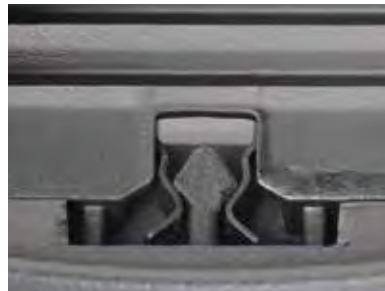
Smudsafvisende, selvlåsende, skrueløs låsemekanisme udført i specialstål
