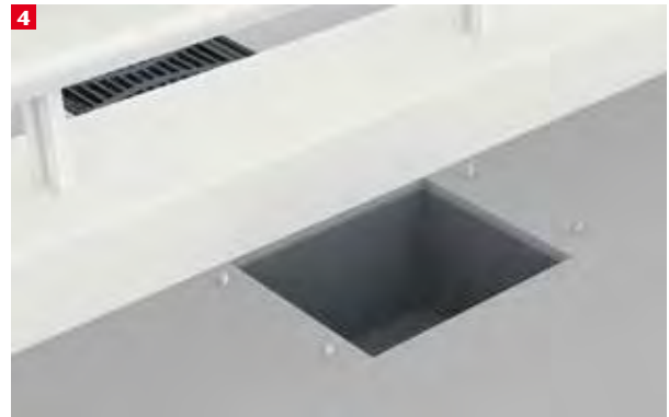
Indvendig afløb skæres fri af membranen
