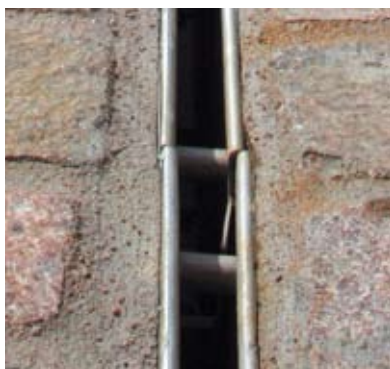
Samling uden brug af Brickslot klips.
