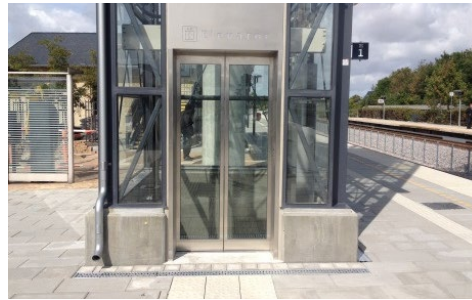
Der er monteret ACO DRAIN® Multiline V100S foran perron-elevatoren
