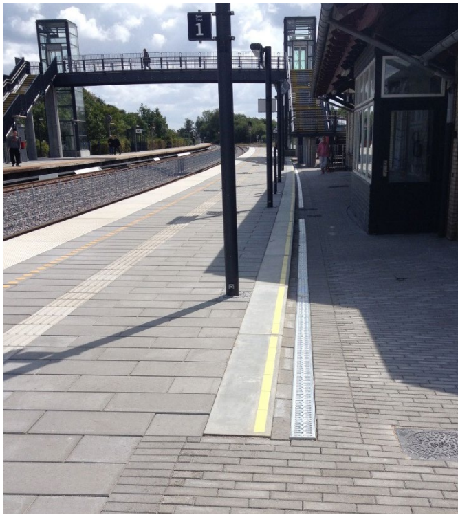
ACO DRAIN® V100S monteret i pesson foran stationsbygningen
