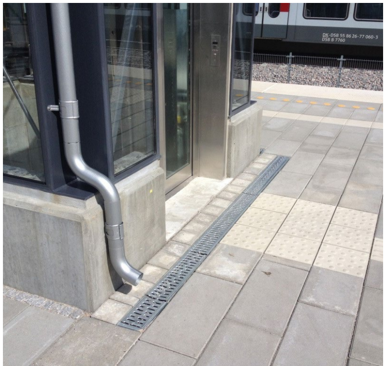
Linjedræn type ACO DRAIN® Multiline V100S, monteret med Spalterist i galvaniseret stål
