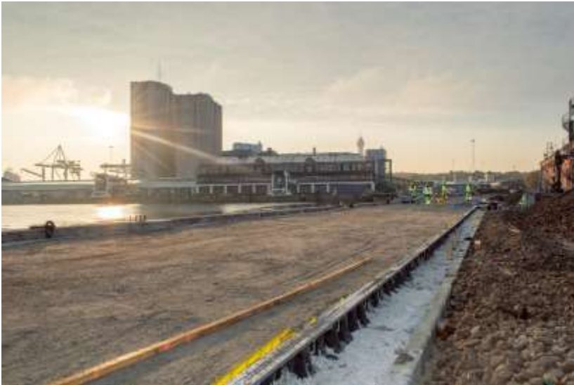
Qmax installation in Sodra Kajen (Sweden)
