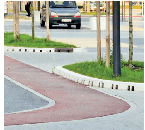
Rundingssten til parkeringspladsindkørsler. Fås på forespørgsel.
