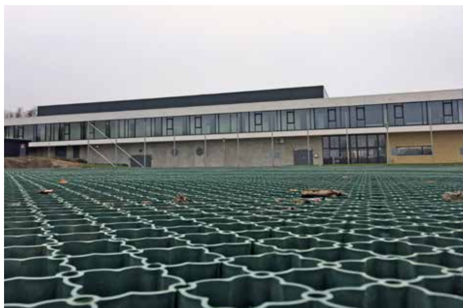
Græsarmeringen inden påfyldning af grus.
