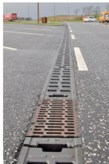
Inspektionsenhed, med mulighed for rensning af renden. Denne er med låsbar riste i støbejern.
