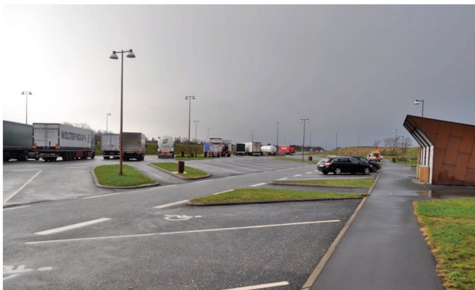
Selv på en regnvejrsdag, er der ikke mulighed for vandpytter, da der er lavet ensidig fald hen til renden. Dette giver et godt helhedsindtryk og tilfredse gæster
